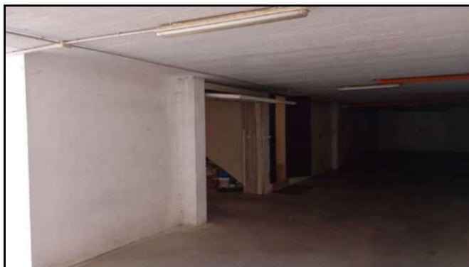
L'accesso al box auto dalla corsia di manovra
