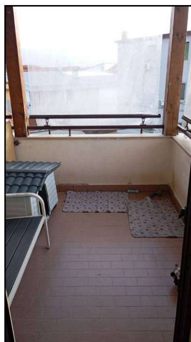
Il balcone lato ovest
